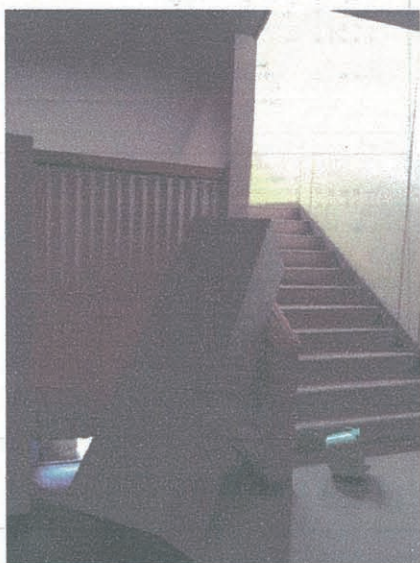
【掃除用具ロッカーが倒れた想定（その後ろは外へ出られる場所）】
