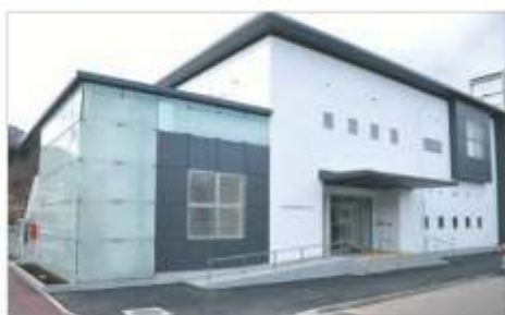
防災センター正面入口
