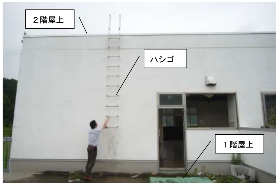
写真 3-1 被災後の防災センター
