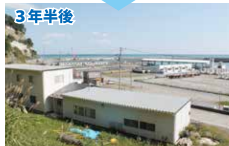
3年半後 市場や養殖施設などほとんどが復旧し、のだ塩工房も下安家地区の高台に移築した。 (平成26年9月 同場所から撮影)
