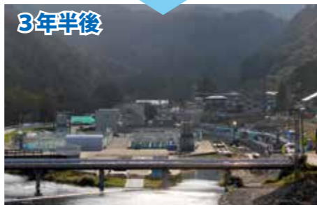
3年半後 下安家漁協並びにさけますふ化場は同年11月に復旧工事が完了した。 (平成26年9月 同場所から撮影)
