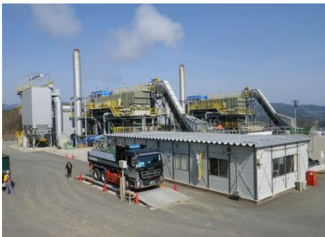
宮古地区仮設焼却炉
