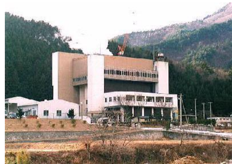
釜石市仮設焼却炉（旧清掃工場）
