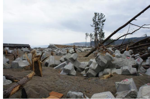
破壊された十府ヶ浦の堤防
